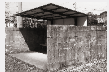
改修予定のブロック塀
