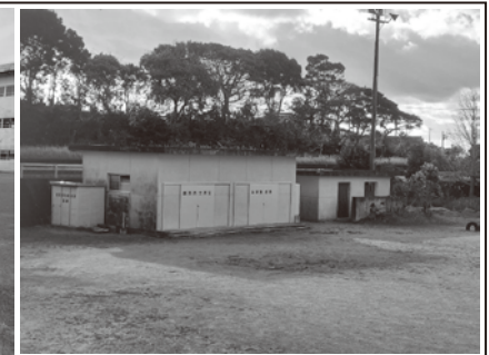
継続使用を要望中のトイレと倉庫
